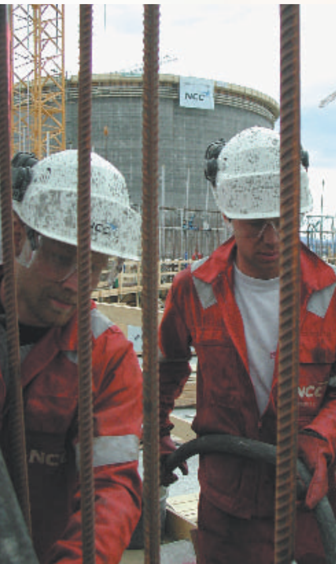
Norge kräver att utländska företag som får uppdrag för oljeindustrin på land måste erbjuda sina anställda norska löner. Ett av projekten är Snøhvit i Hammerfest. Norrmannen Øyvind Lien och svensken Andreas Edin arbetar på en tank för flytande naturgas. Foto: Björn Lindahl
